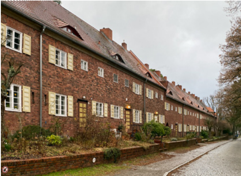
Abbildung 3 Homogene Dächer einer denkmalgeschützten Siedlung.
