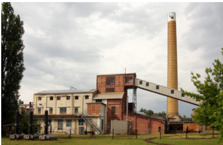
Abbildung 37 Denkmal Brikettfabrik Louise mit PV-Anlage, Dohmsdorf.
