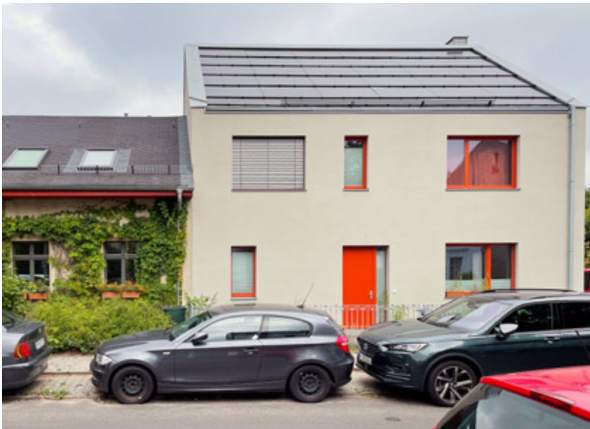
Abbildung 40 Dachintegrierte PV-Anlage auf Neubau neben einem Denkmal.
