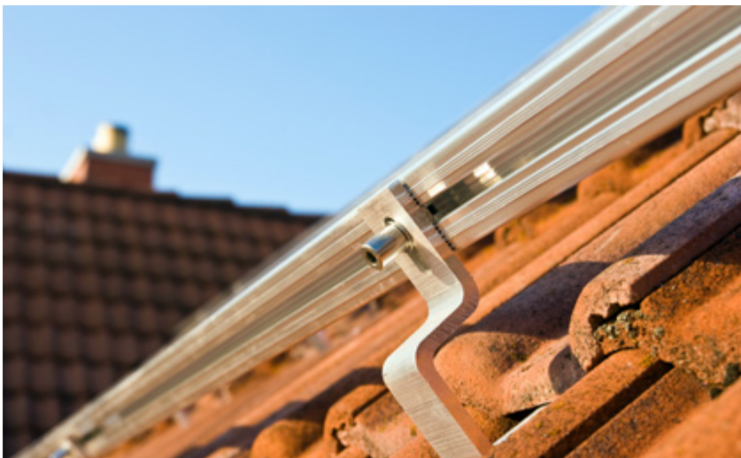
Abbildung 24 Dachhaken für die Aufdachmontage.
