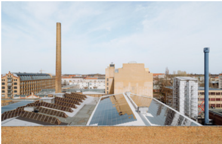
Abbildung 36 PV-Anlagen auf denkmalgeschützten ehemaligen Fabrikgebäuden.
