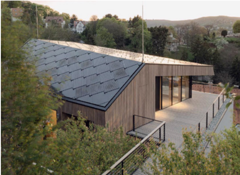
Abbildung 20 Bauwerkintegrierte Photovoltaik- schindeln.
