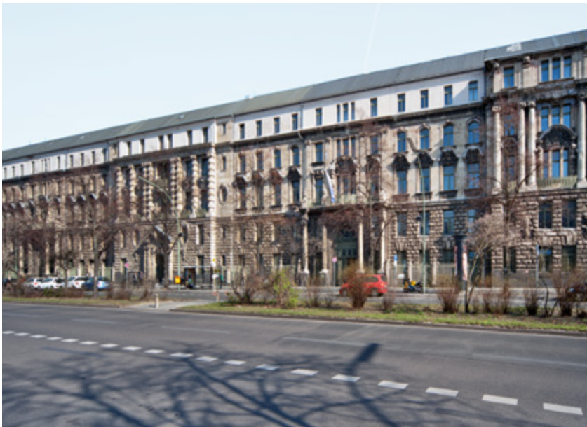
Abbildung 38 Denkmal mit überformtem, nicht bauzeittypischem Dach.
