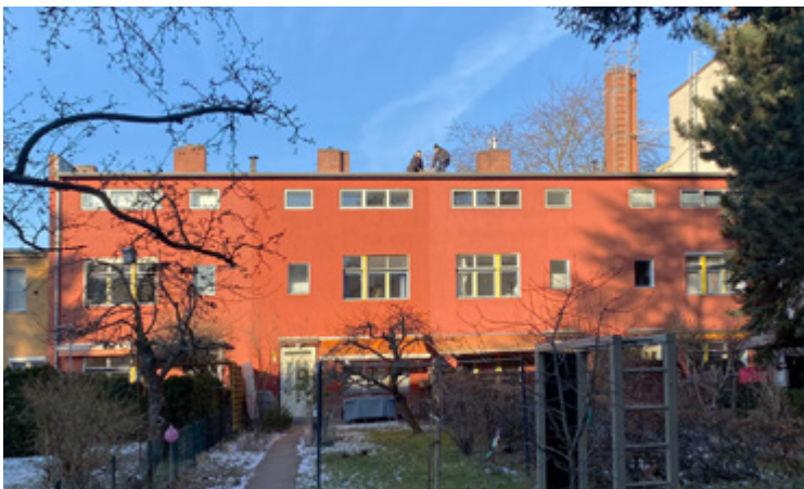
Abbildung 58 Bemusterung einer PV-Anlage in Welterbesiedlung.
