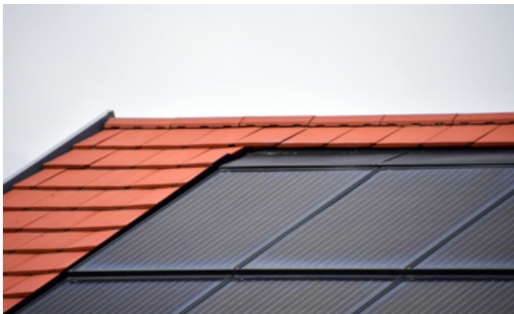
Abbildung 25 Indach-PV-Anlage.
