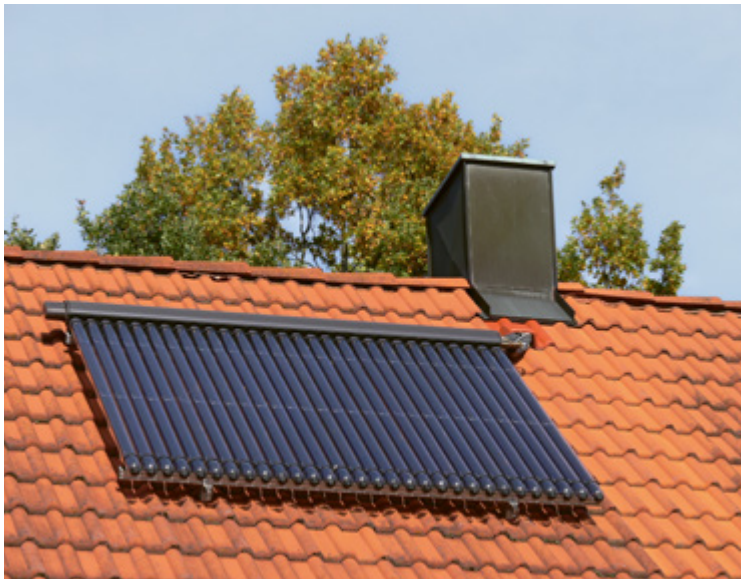
Abbildung 26 Röhrenkollektor.
