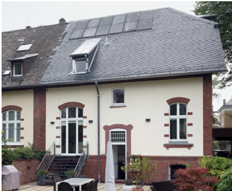
Abbildung 49 Farblich angepasste PV-Anlage auf einem Denkmal.
