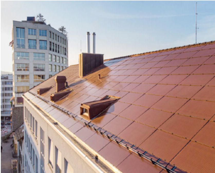
Abbildung 18 Bauwerkintegrierte Photovoltaik in Zürich – Solarmodule mit integriertem farbigem Film.
