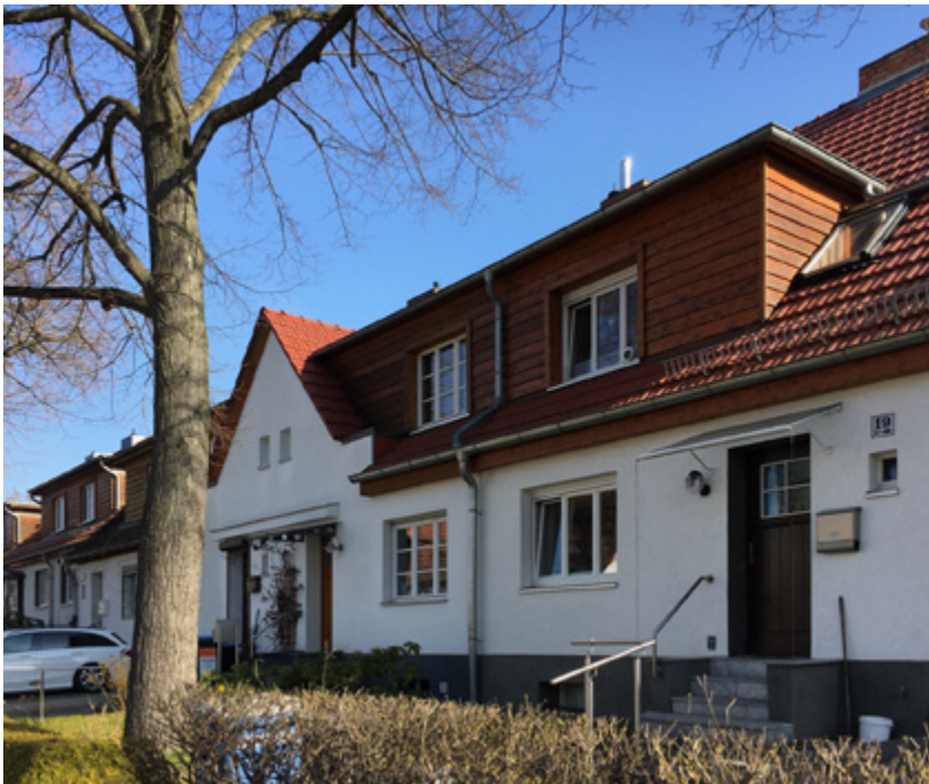
Abbildung 59 Dachflächen in einer denkmalgeschützten Gesamtanlage.
