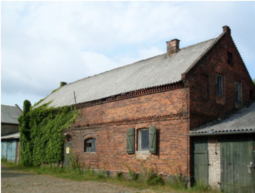
Abbildung 41 Denkmalgeschütztes Wirtschafts- gebäude.
