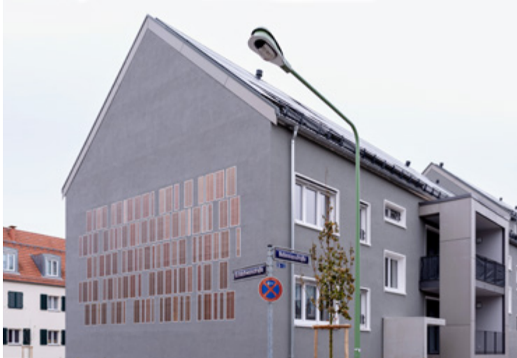
Abbildung 56 Gestaltete Photovoltaikanlage an einer Brandwand.
