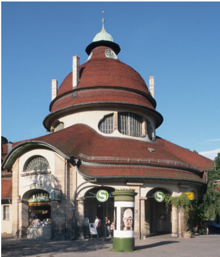
Abbildung 45 Aufwendig ausgebildetes Dach des S-Bahnhofs Mexikoplatz.
