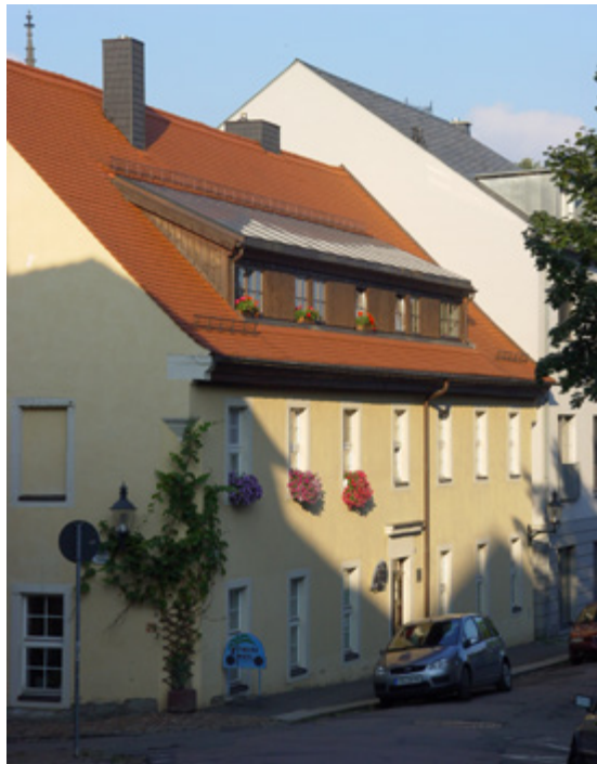
Abbildung 54 Solarkollektoren auf einer Gaupe.
