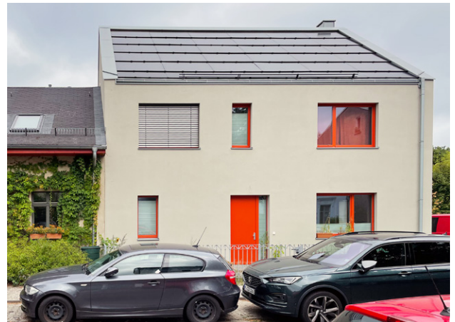
Abb. 8: Dachintegrierte PV-Anlage auf Neubau neben einem Denkmal
