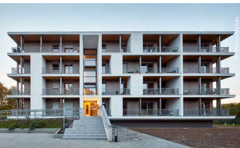
Abb. 1: Der hybride Viergeschossiger aus vornehmlich Holz und Stahlbeton wartet mit 30 barrierefreien Wohneinheiten auf
