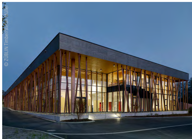
Abb. 1: Das Innovations- und Anwendungszentrum der Jowat SE mit überdachtem Haupteingangsbereich. Eine bis zu 2,50 m auskragende Vordachkonstruktion schützt die Hauptfassaden vor Wind und Wetter. Die Sekundärfassade mit den verschränkten Holzstaketen bildet einen Arkadengang. Die außen auf dem Sockel rund um das Gebäude stehenden Staketen verbinden als symbolisierte Klebstoffäden Bodenplatte und Dachkonstruktion miteinander.
