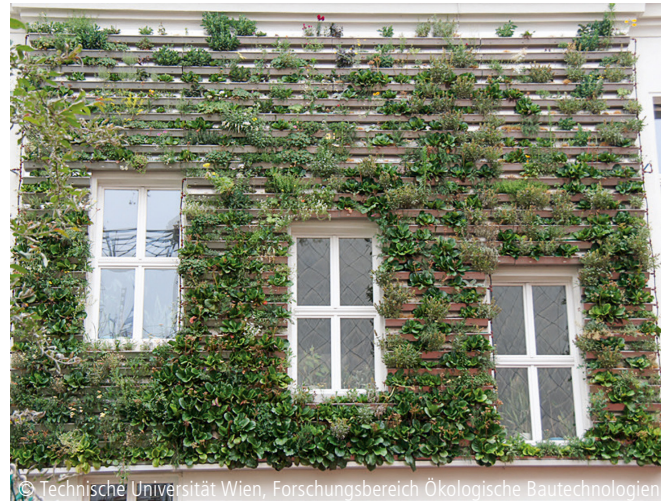
Abb. 3: Das wandgebundene Trogssystem an einer Außenfassade der Schule GRG 7, Wien
