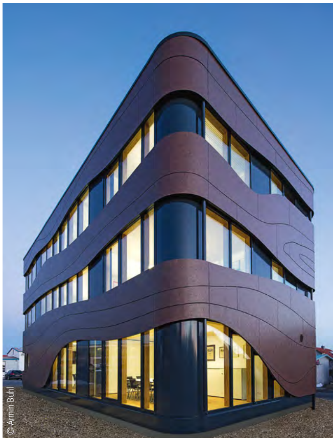
Abb. 1: Gapp Holzbau arbeitet auf einer Produktionsfläche von über 1 750 m 2 und hat zusätzlich noch einen umfangreichen Lagerbereich auf dem 7 500 m 2 großen Firmenareal
