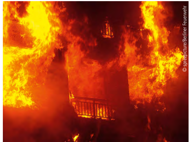
Abb. 2: Die Brandausbreitung durch Flammen an der Außenwand darf vor dem Löschangriff der Feuerwehr nicht mehr als zwei Geschosse überschreiten. Zusätzlich ist eine Gefährdung der Rettungskräfte durch großflächig abstürzende, brennende oder nichtbrennende Fassadenteile bzw. durch brennendes Abtropfen auszuschließen.
