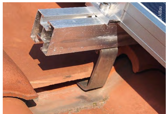
Abb. 6: Verkürzter Ziegel, Fußrippe komplett entfernt: zu große Einschränkung der Regensicherheit
