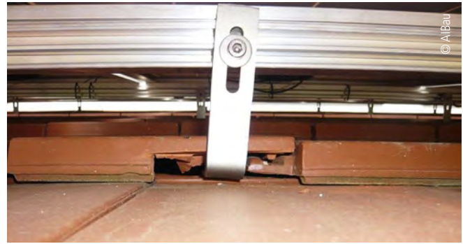
Abb. 4: Zu große Ausnehmung der Rippen und Falze im Flachziegel
