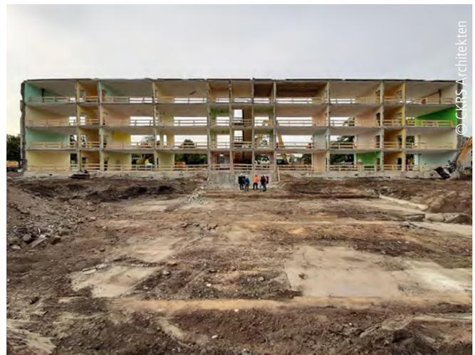
Abb. 2: Das alte Hauptgebäude, Plattenbau Typ Erfurt, wurde entkernt und einer nachhaltigen Bauweise angenähert
