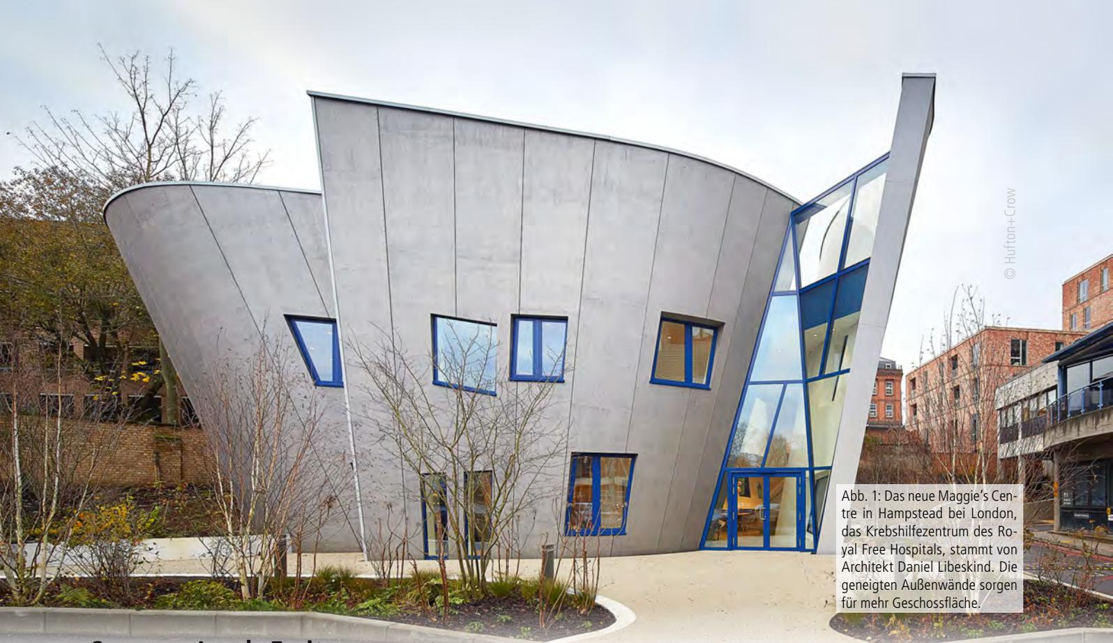
Abb. 1: Das neue Maggie's Centre in Hampstead bei London, das Krebshilfezentrum des Royal Free Hospitals, stammt von Architekt Daniel Libeskind. Die geneigten Außenwände sorgen für mehr Geschossfläche.
