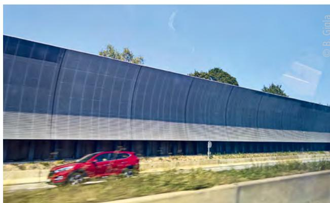
Abb. 1: Lärmschutzwände an Straßen sollen hoch genug sein (keine Sichtverbindung zum Immissionsort), dürfen keine Unterbrechungen aufweisen und sollen den Schall möglichst ohne Reflexionen lotrecht nach oben ableiten. (A9 bei München-Fröttmaning)
