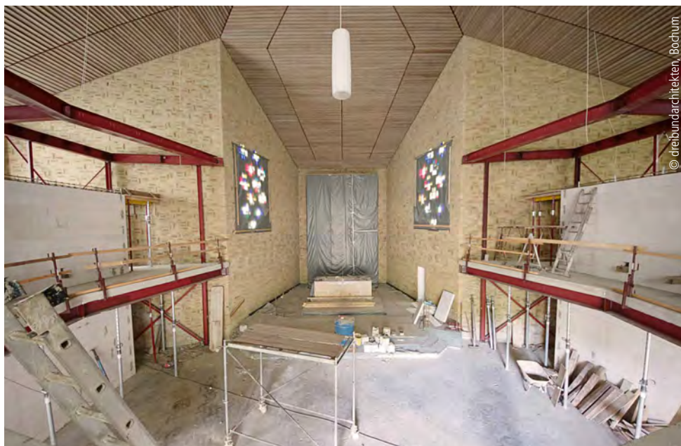
Abb. 2: Einbau der neuen Emporen
