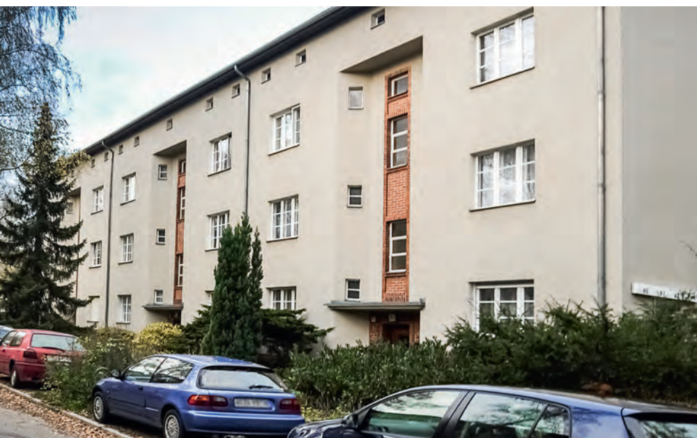
Abb. 1: Am Ende des Ostpreußendamms in Lichterfelde-Süd sind insgesamt 841 Wohnungen aus den 30er- und 60er-Jahren zu sanieren. Das Quartier erstreckt sich entlang Stadtgrenze zu Teltow.
