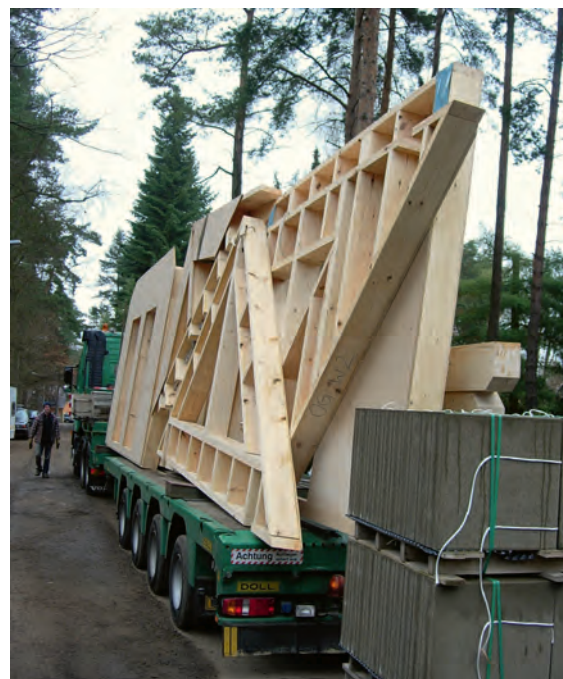
Abb. 3: Die Vorfertigung von Modulen reduziert den Aufwand vor Ort und die Bau-Dauer erheblich. (ZMH Arche Naturhaus)
