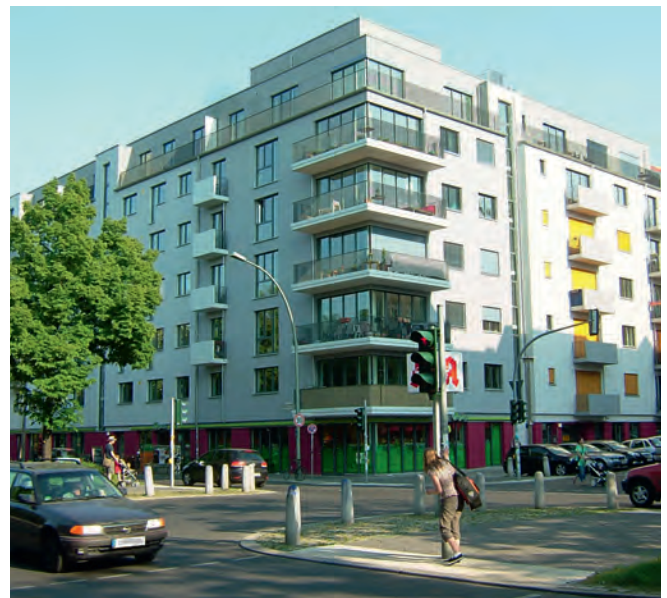
Abb. 2: Grauwasserrecycling und Wärmerückgewinnung für 123 Personen im Passivenergie-Mietshaus am Arnimplatz in Berlin-Prenzlauer Berg mit 41 Wohn- und 4 Gewerbeeinheiten. (Foto: König)
