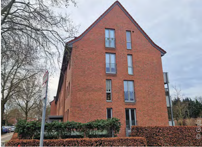
Abb. 2: Instandgesetztes Mehrfamilienwohngebäude aus den 1950er-Jahren. Die heutigen Mindestanforderungen an den Schallschutz lassen sich nur mit sehr hohem Aufwand erreichen, da das alte Tragwerk eine geringe Direktschalldämmung aufweist. Mangelnder Schallschutz ist ein Hauptkriterium für Abriss und Neubau.
