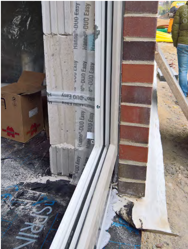
Abb. 2: Sachgerechter Einbau eines Blendrahmens in einer Außenwand aus Verblendmauerwerk. Der Einbau erfolgt in der Dämmebene an der Tragschale aus Kalksandstein-Planelementen. Die Befestigungspunkte und die innen- und außenseitige Abdichtung sind zu erkennen.
