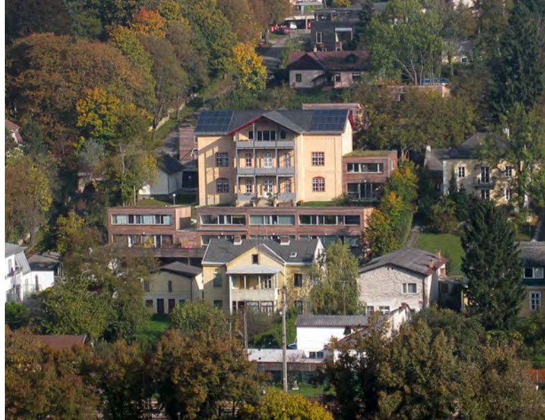
Abb. 1: Die Gründerzeitvilla am Rande von Wien wurde aufwendig saniert. Die in ihr Dach integrierte Solarthermie unterstützt den Pelletkessel. (Foto: Architekturbüro Reinberg ZT)
