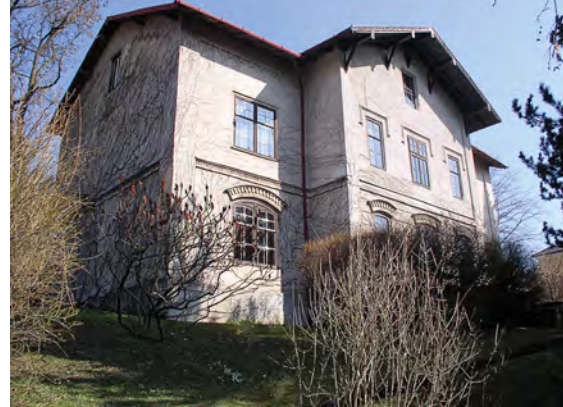
Abb. 4: Zustand der Villa vor Beginn der Arbeiten. (Foto: Architekturbüro Reinberg ZT)
