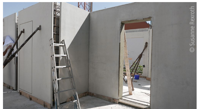
Abb. 9: Chemnitz: Solldurchbruch (links im Foto) für einen späteren Türereinbau in der Fertigteilwand (vgl. Abb. 8)
