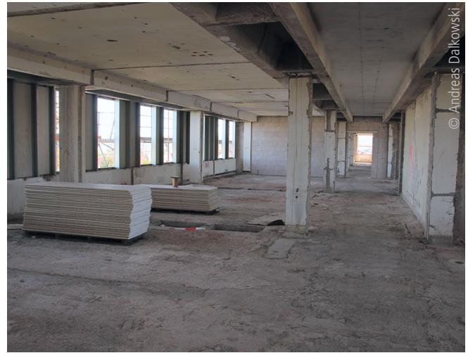
Abb. 4: Erfurt: Die ehemalige Zahnklinik wurde entkernt. Das Skelett des Großtafelbaus der Serie WBS 70/G konnte wieder- und weiterverwendet werden.
