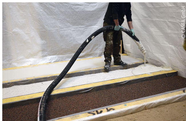
Abb. 2: Ausbringen des Schaumgipses im Technikum zur Hohlraumbefüllung in Holzbalkendecken mit unterschiedlichen Einlagematerialien
