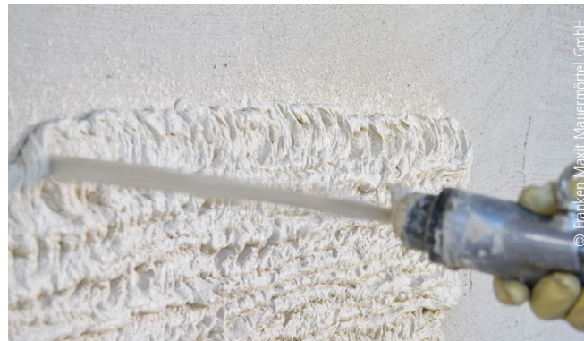
Abb. 6: Aufspritzen der ersten Lage der neu entwickelten Dämmung
