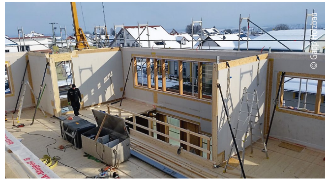
Abb. 4: Schnell zum energieeffizienten Gebäude: die Wandmontage im ersten Obergeschoss
