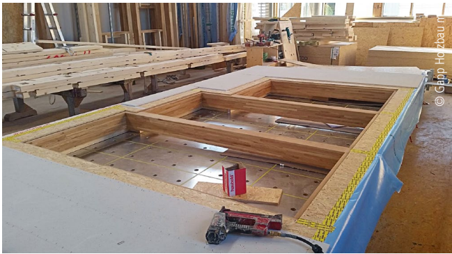
Abb. 3: In die Konstruktion integrierten die Holzbau-Experten eine tragende Pfosten-Riegel-Fassade aus Eiche
