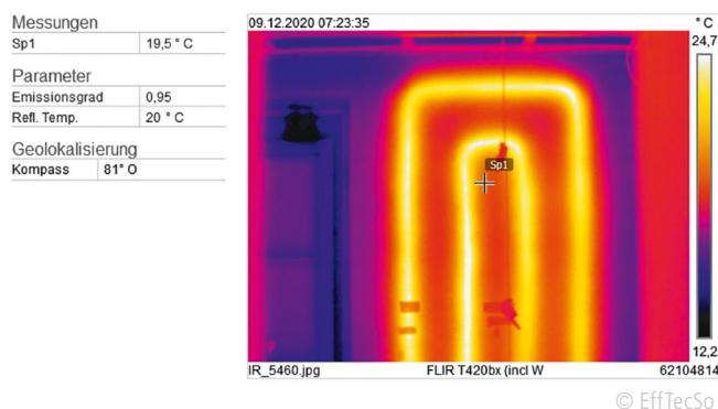
Abb. 7: Thermografie Außenwand (Heizleitungen)
