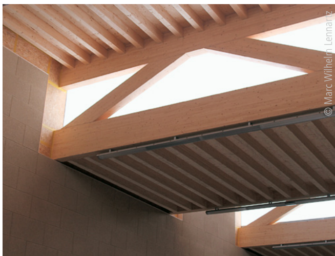
Abb. 6: Die Polycarbonat-Lichtelemente der aufspringenden Dachauskragungen bringen angenehmes und blendfreies Tageslicht in die Sporthalle
