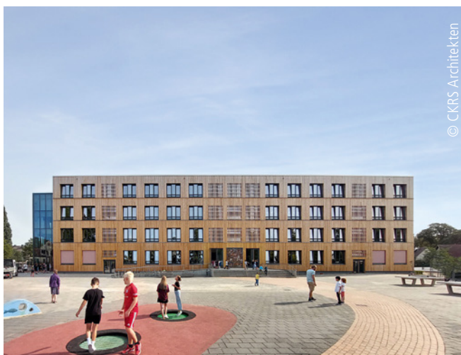
Abb. 1: Front des sanierten Hauptgebäudes mit einer Fassade aus Lärchenholz
