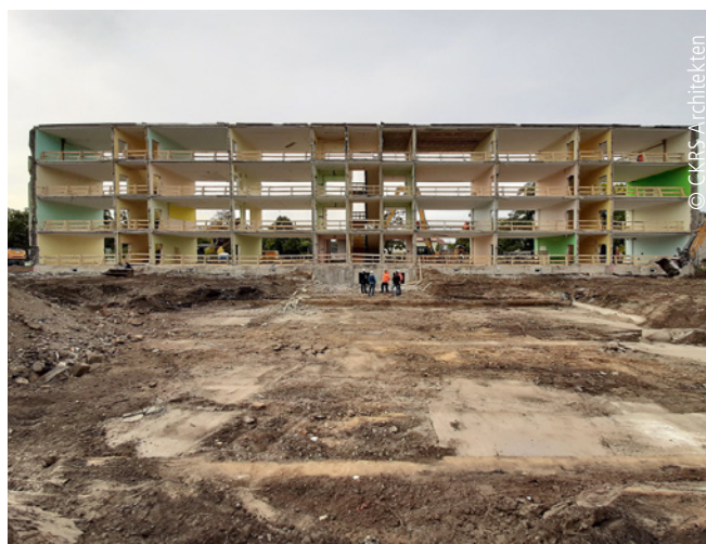
Abb. 2: Das alte Hauptgebäude, Plattenbau Typ Erfurt, wurde entkernt und einer nachhaltigen Bauweise angenähert
