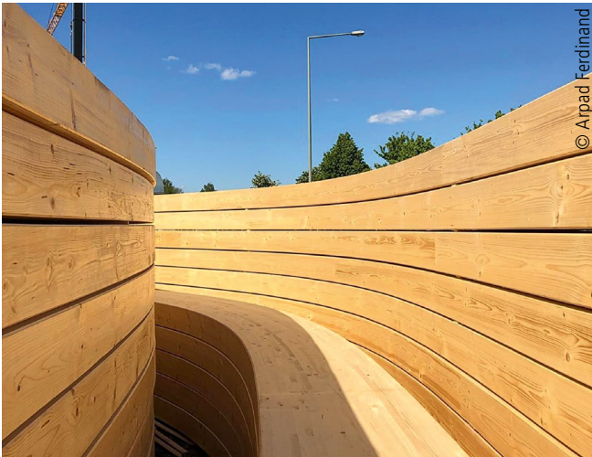
Abb. 4: Schichtholzbalken bilden Bogendächer aus, die im gleichen Rhythmus nebeneinander angeordnet sind
