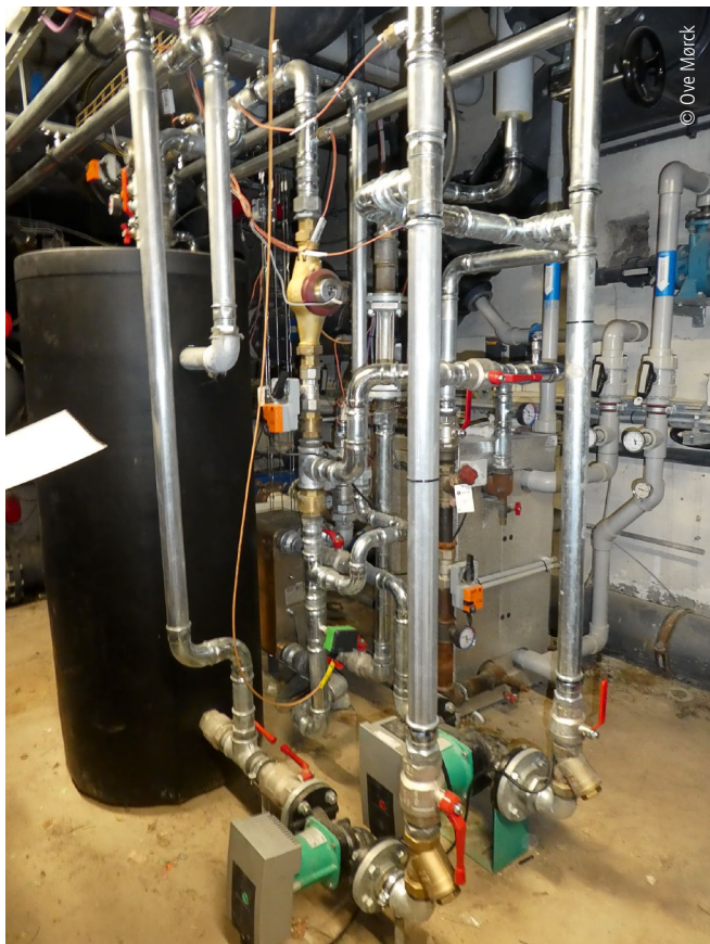
Neuer Wärmetauscher an der Fernwärme- und Rohrinstallation zur Einleitung von Wärme aus der Wärmepumpe
