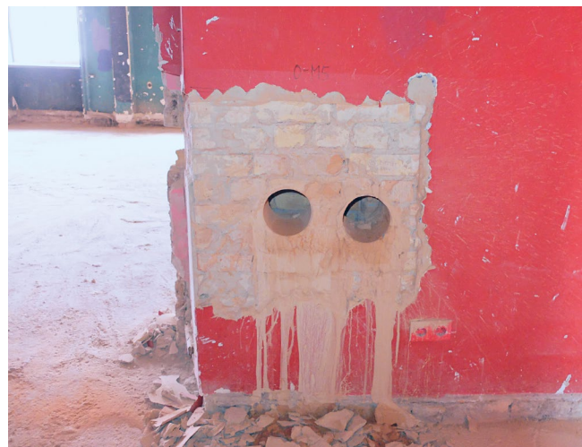
Abb. 2: Gezielte Bohrkernentnahme nach Entfernen des Putzes
