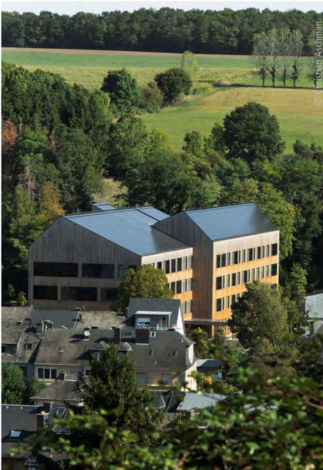
Abb. 4: Schulbau in Luxemburg: 150 kW Solarthermie-Fassade und 320 kW PV-Anlage am Lycée technology pour professions de santé (2019) in Ettelbruck (Fabeck Architectes)
