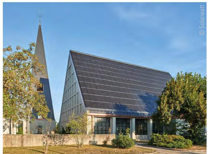
Abb. 3: Sanierter Sakralbau in Bayern: 78 kW Solardach an der Kirche St. Wunibald in Georgensgmünd (2018) (Planer: Johannes Wunram)
