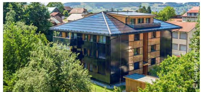
Titelbild aus dem Fachartikel »Plusenergiehaus: Sanierung mit Solarmodulen« von Achim Pilz ab S. 14
